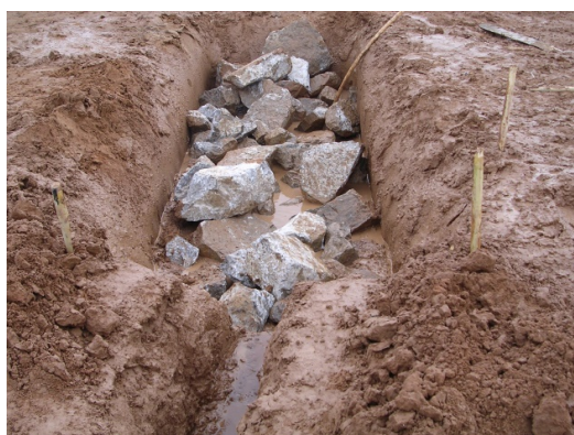
(b) 降水及垫层施工
