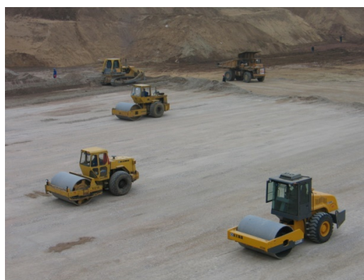
(b) 降水及垫层施工
