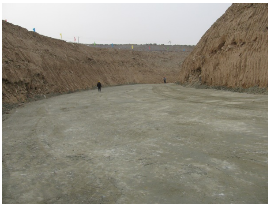
冷却塔碎石垫层施工
