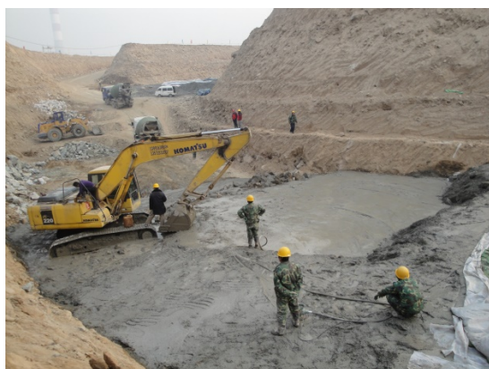
基坑开挖及毛石混凝土回填
